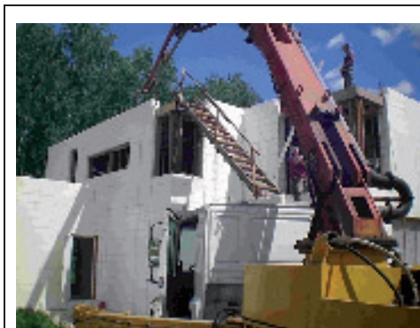
Рис.8 Заливка бетона с помощью бетононасоса
