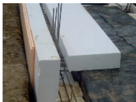
Рис.2 Утепление фундамента
