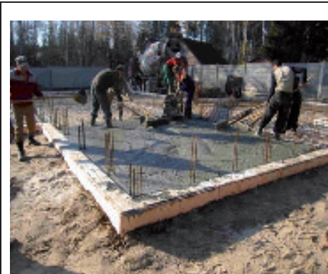
Рис.1 Возведение и утепление фундамента
