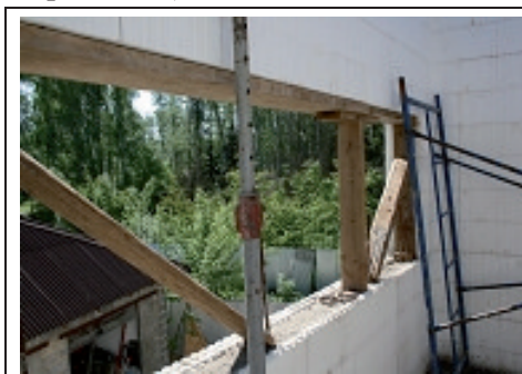
Рис.7 Возведение оконных проемов
