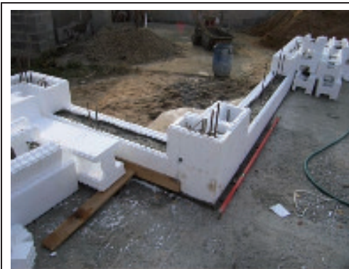
Рис.3 Монтаж первого ряда блоков несъемной опалубки
