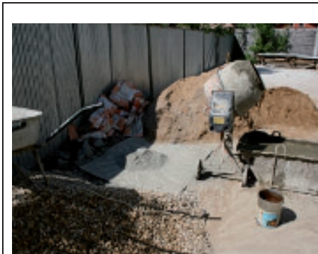
Рис.9 Приготовление бетона на строительной площадке
