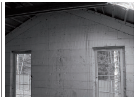
Рис.12 Возведение фронтона
